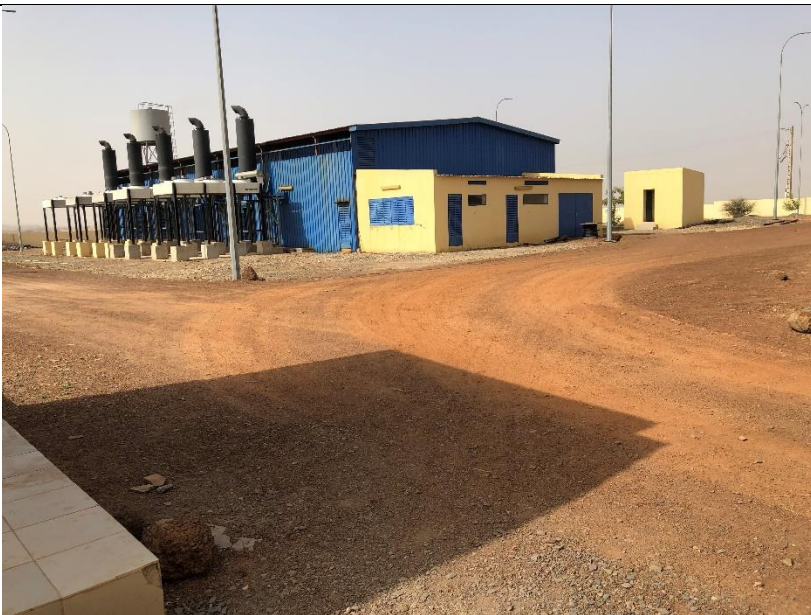
La centrale de Nioro du Sahel, 18/02/20
