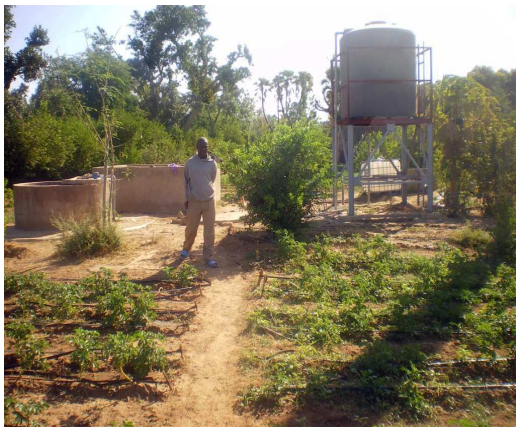
les lignes noires de goutteurs et dans le fond du jardin le réservoir alimentant ces lignes. Celui-ci est alimenté par la pompe plongeant dans le puits.
